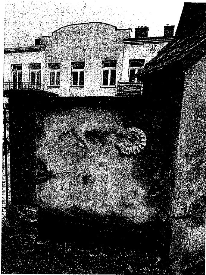
Fot. nr 1 odcinek muru A – B
