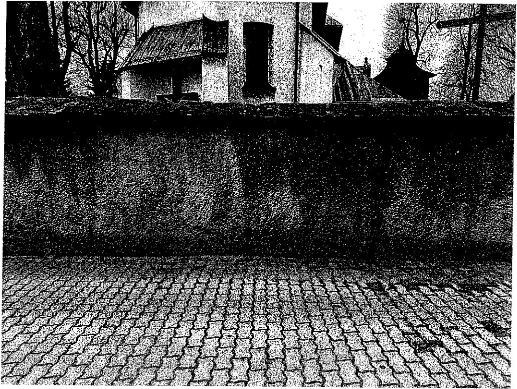
Fot. nr 11 odcinek muru D – E
