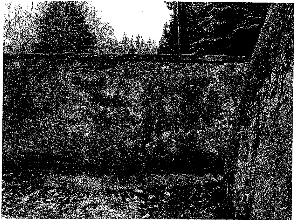
Fot. nr 19 odcinek muru G – H
