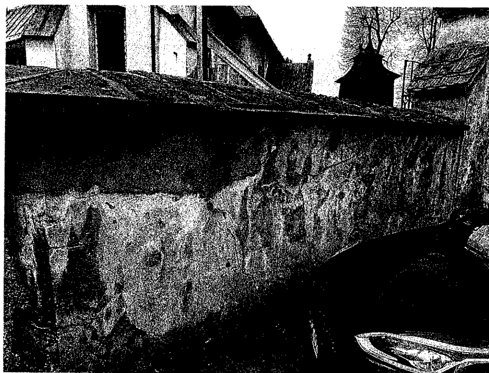
Fot. nr 6 odcinek muru C – D
