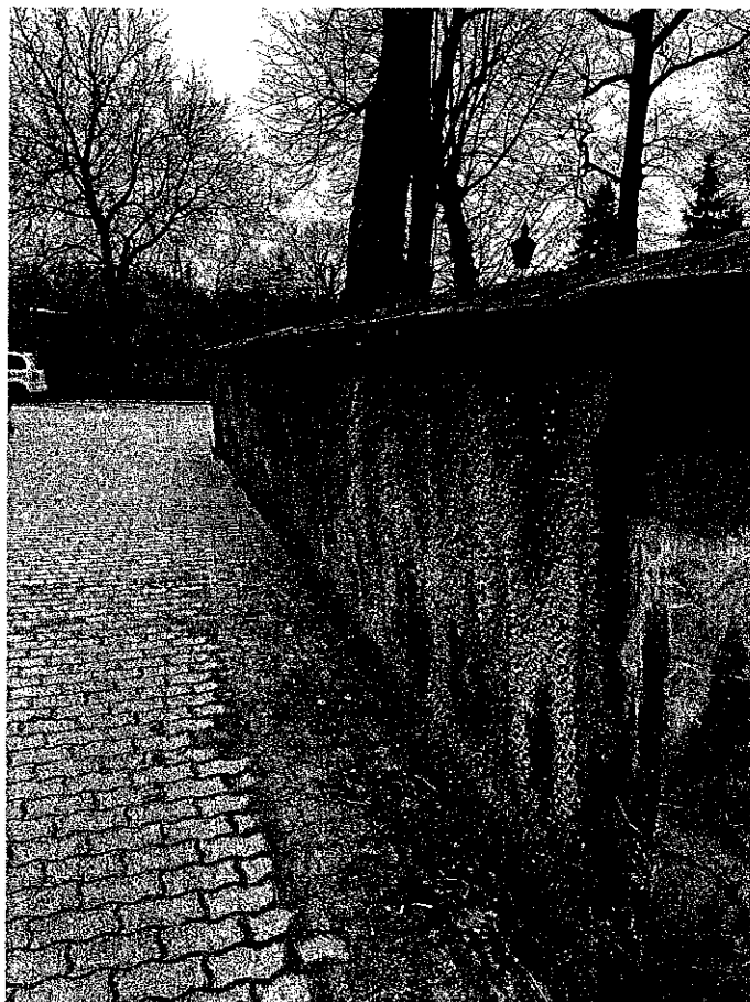
Fot. nr 10 odcinek muru D – E
