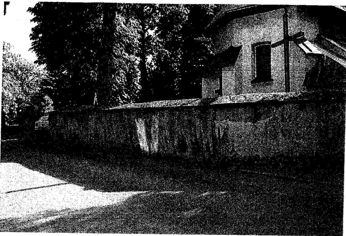
Zdj. nr 2. Mur ogrodzeniowy wraz z dwoma bramami przy koś. św. Mikołaja w Skale. Widok na mur os strony ulicy Kościelnej. W tej części mur jest najgorzej zachowany. Mocno odchylił się od pionu. Spękania nie obejmują jedynie tynku, ale także wążek kamienny, z którego wykonany jest mur.
