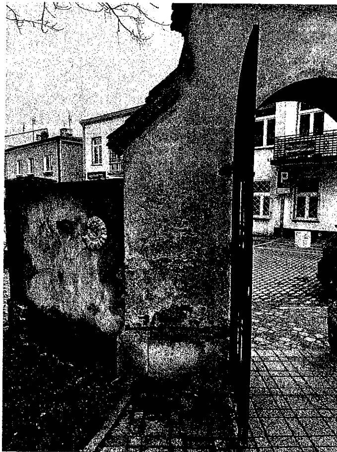
Fot. nr 2 brama wejściowa odcinek muru B – C
