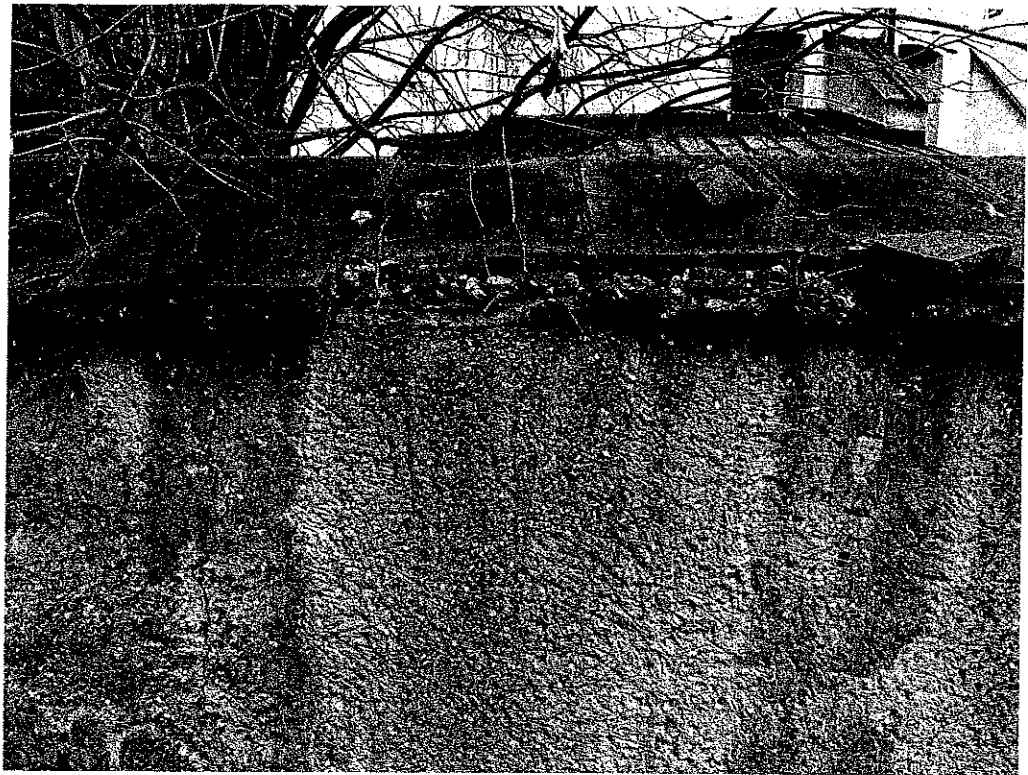
Fot. nr 21 odcinek muru G – H
