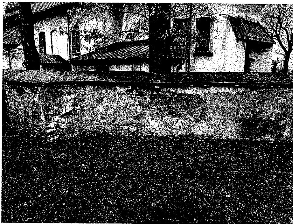
Fot. nr 18 odcinek muru F – G
