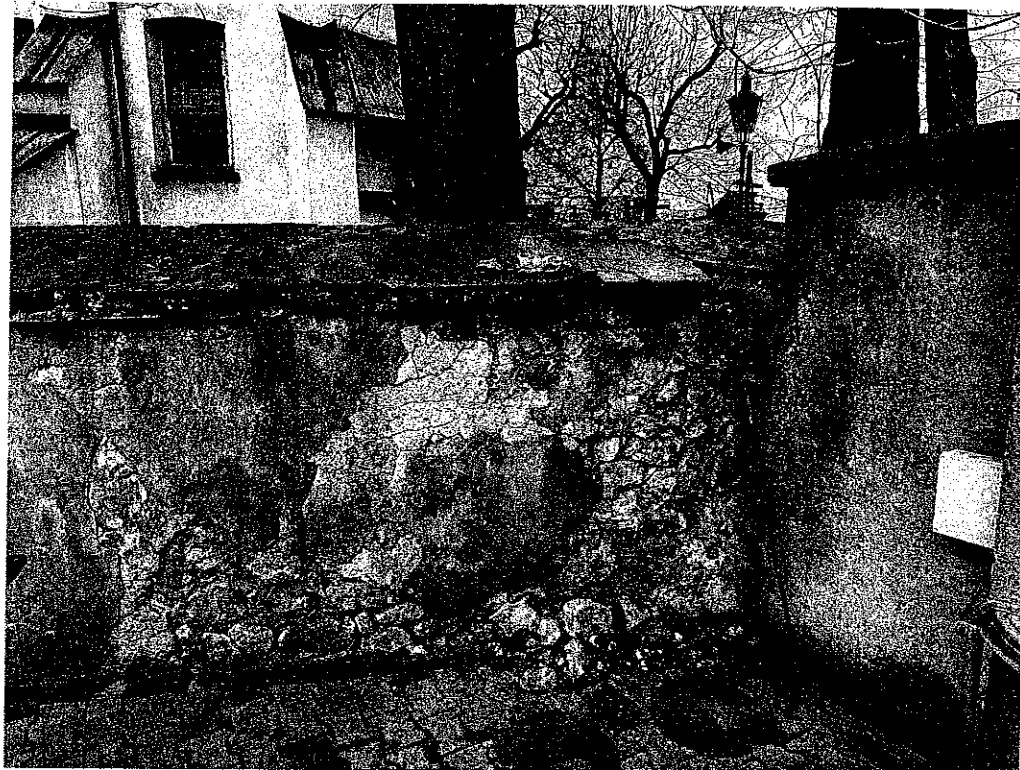
Fot. nr 17 odcinek muru F – G
