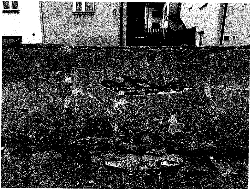
Fot. nr 8 odcinek muru D – E
