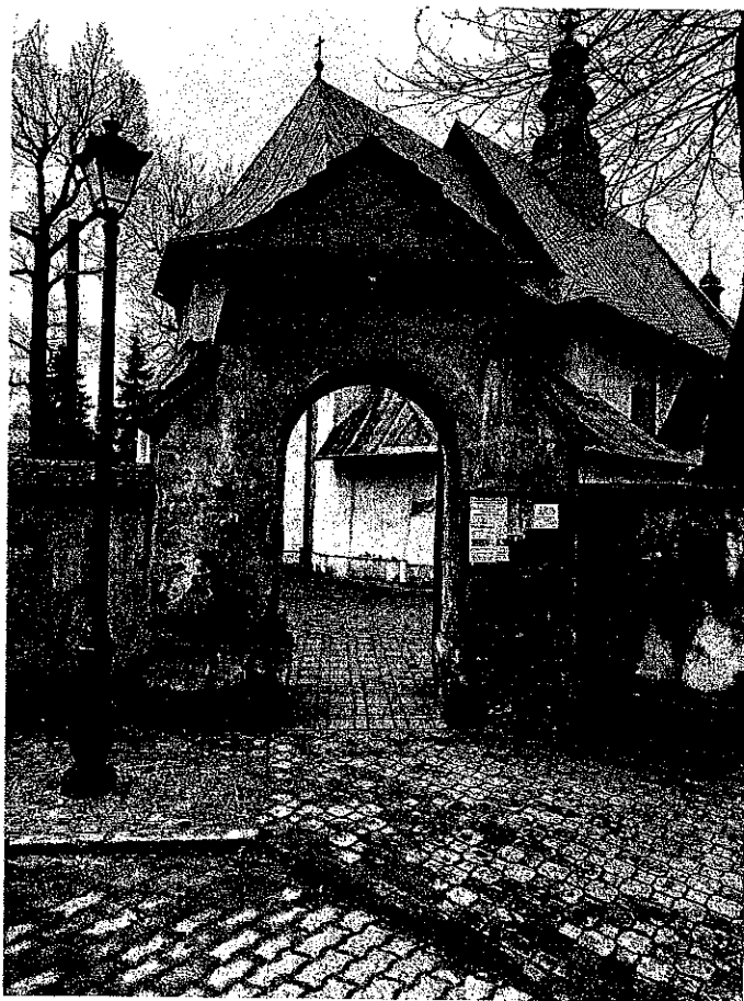
Fot. nr 4 brama wejściowa odcinek muru B – C
